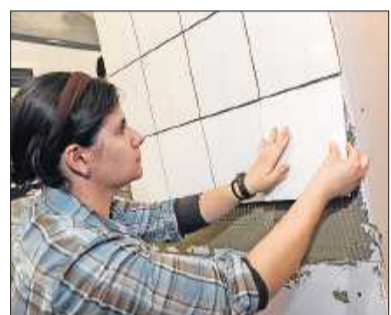
VOLLE KONZENTRATION Merke: Beim Anbringen der Fliesen darauf achten, dass der Abstand stimmt, sonst werden die Fugen ungleich breit.
